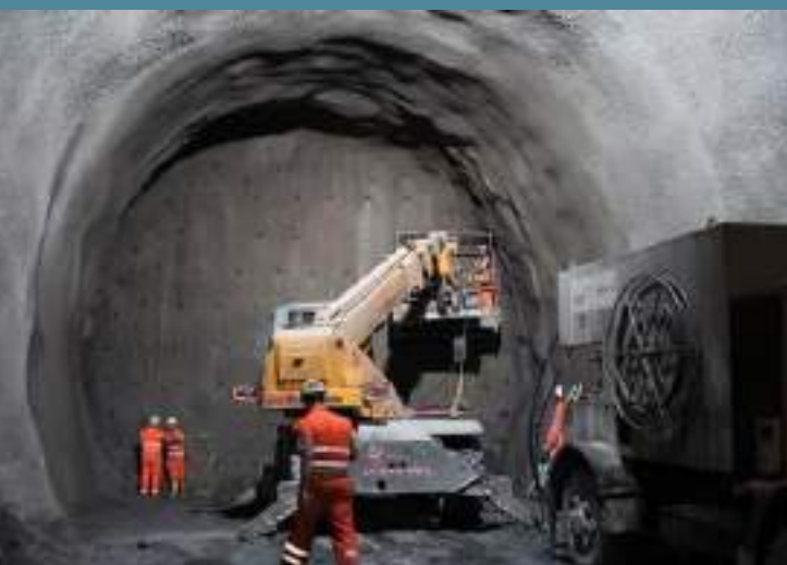
Construcción de la Línea 12 del SCT Metro de la CDMX.
