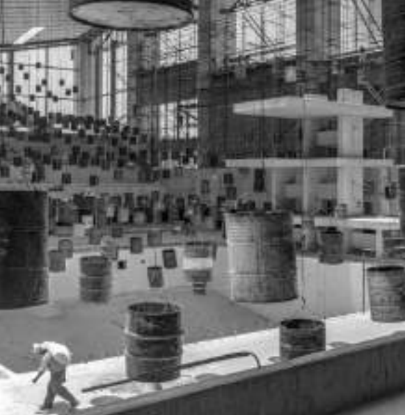
Interior de Alberca Olímpica meses antes de los Juegos Olímpicos de 1968, sistema utilizado para darle forma a la cubierta a base de pesos repartidos
